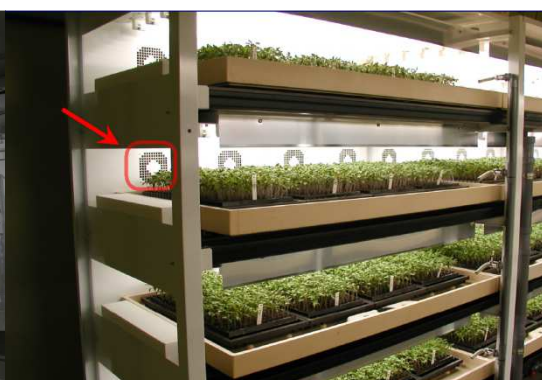
Slika 2.13: Rastlinska farma Tokushima Seedling - sistem prezračevanja z odsesavanjem zraka na vzdolžni strani gojitvenih plošč (Maruo, 2012)
