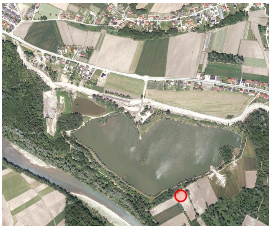
Priloga A 22: Digitalni orto foto posnetek površinskega kopa Duplek (GURS, 2016)
