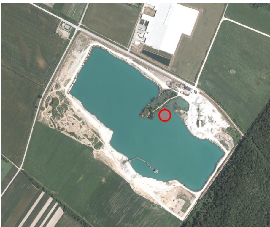
Priloga A 19: Digitalni orto foto posnetek površinskega kopa Dobrovnik (GURS, 2016)
