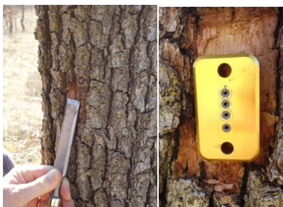
Slika 9: Odstranitev dela skorje in namestitev šablone za pomoč pri vrtanju lukenj
