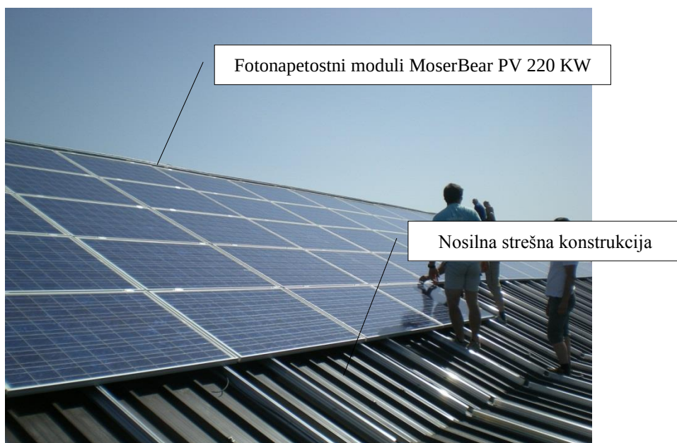
Slika 12: Gradnja sončne elektrarne Novak (Novak, 2010)
