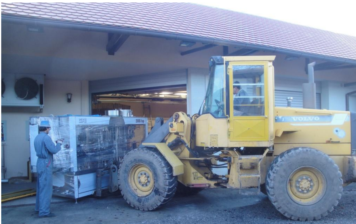
Slika 5: Raztovarjanje komponent polnilne linije na vhod pred prostorom, kjer stoji linija (foto: Prus, 2012)
