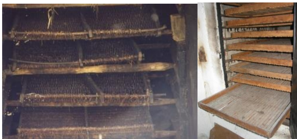
Slika 8: Notranjost sušilnice - primer pletene in mizarsko izdelane lese (Kolenc, 2009)
