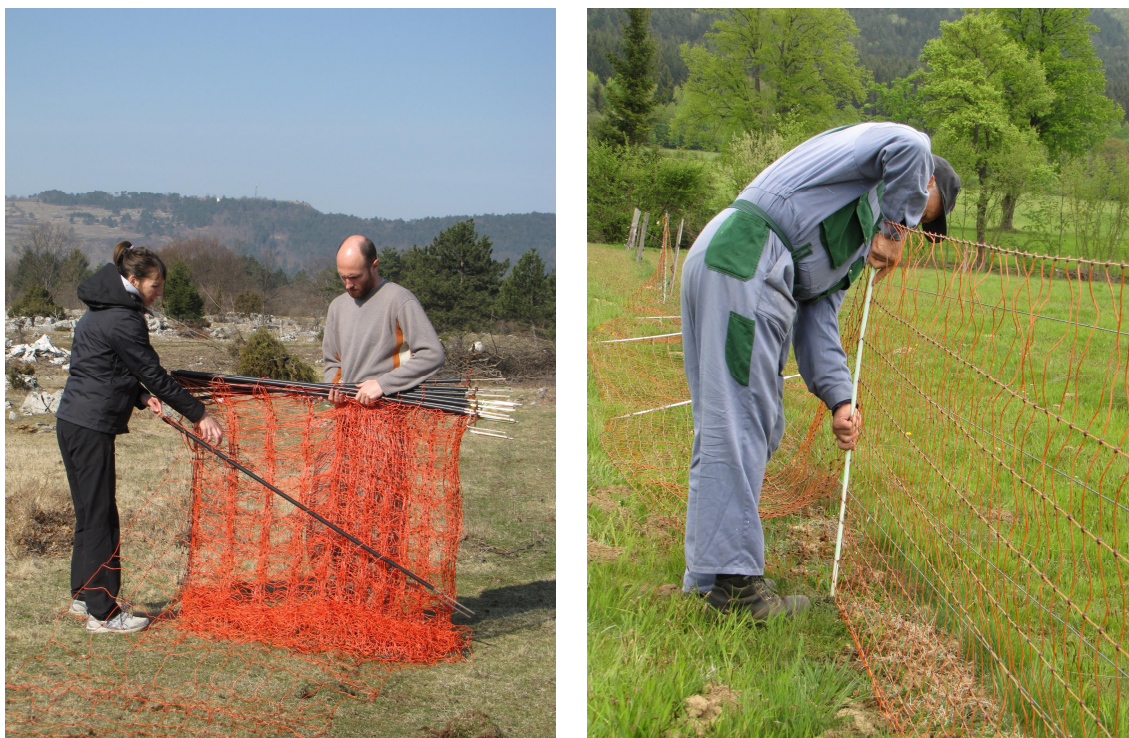
Slika 4: Raztegovanje visoke elektromreže po površini (levo) in njena postavitve (desno) (foto: M. Vidrih)
