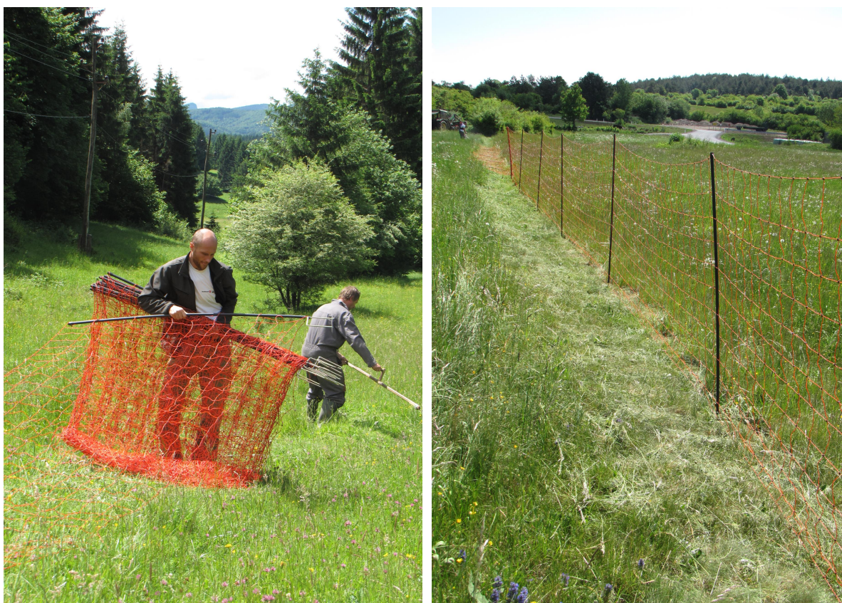
Slika 3: Priprava trase (levo) po kateri kasneje poteka visoka elektromreža za novo ogrado (desno) (foto: M. Vidrih)
