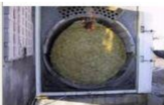
Slika 24: Kotel na okrogle slamnate bale z močjo 1MW toplotne moči (Al-Mansour, 2016)
