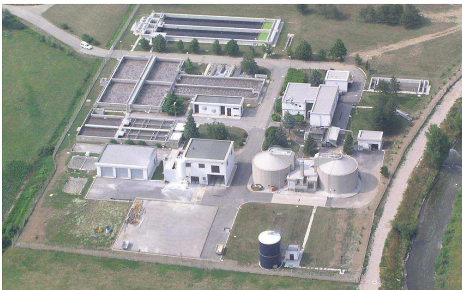
Slika 1: Centralna čistilna naprava Ajdovščina ( www.ksda.si ) Figure 1: Central Wastewater Treatment Plant ( www.ksda.si )
