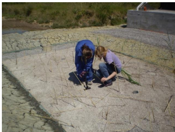
Slika 13: Saditev navadnega trsta ( Phragmites australis ) v rastlinsko čistilno napravo (foto: Aleksandra Krivograd Klemenčič)
