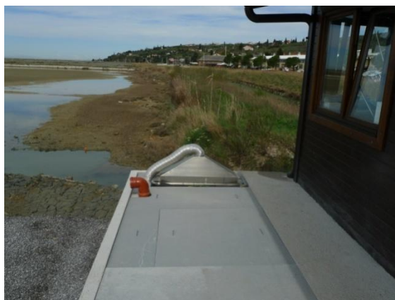
Slika 11: Jašek pred Sanbox prototipom z izvodilom kaskadnega sušilnika (foto: Tjaša Cenčič)
