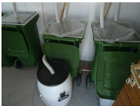
Slika 7: Šotna filtra v zelenih zabojnikih za odpadke (na levi), biofilter v zelenem zabojniku za odpadke (na desni) (foto: Tjaša Cenčič)
