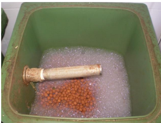
Slika 9: Razpršilna šoba in biofilter z ekspandirano glino (foto: Tjaša Cenčič)
