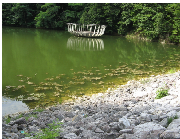
Slika 3: Krožni prelivni objekt ob pregradi
