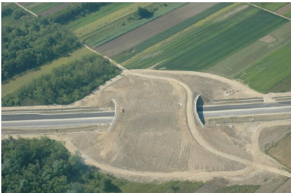
Slika 6: Gradnja ekodukta na odseku AC Beltinci – Lendava; foto: Ljubica Dalla Valle (Stergar M. in Stergar B., 2010: 923).
