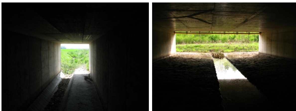
Slika 23: Objekt 6, podhod za male živali, z indeksom odprtosti 0,19 (levo) in objekt 3, zasilni izhod za živali pred visokimi vodami, z indeksom odprtosti 1,29 (desno).
