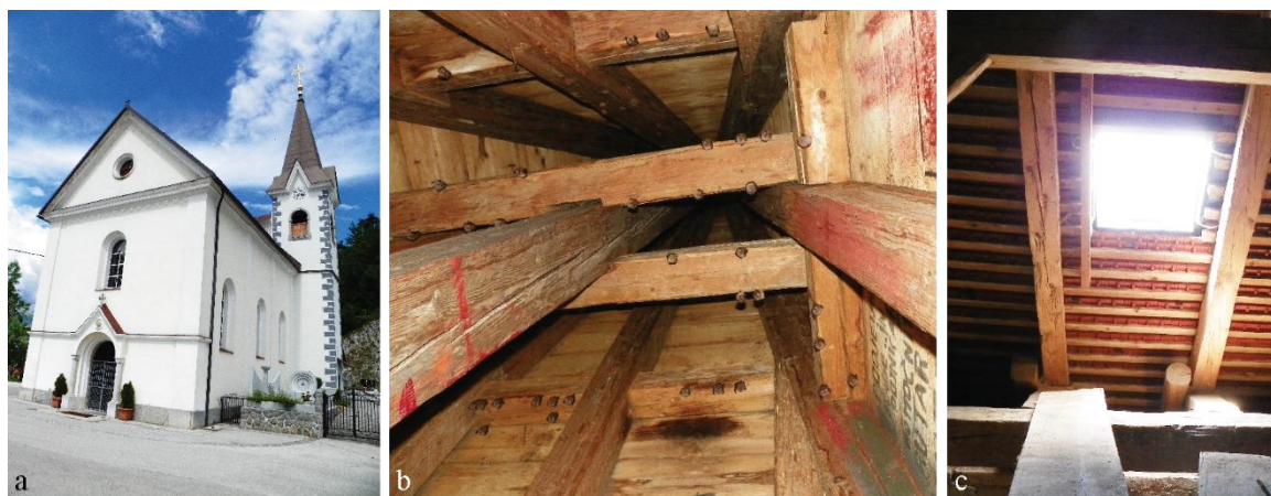
Slika 7: Cerkev Sv. Urha in Sv. Martina na Zaplani. a) Cerkev ima štiri primerne preletne odprtine in prav vse se nahajajo na zvoniku. b) Podstrešni predel nad zvonovi je z notranje strani v celoti podeskan. c) Velik del cerkvenega podstrešja je osvetljen z dnevno svetlobo, ki prehaja skozi strešno okno (foto: Jasmina Kotnik, 2013).
