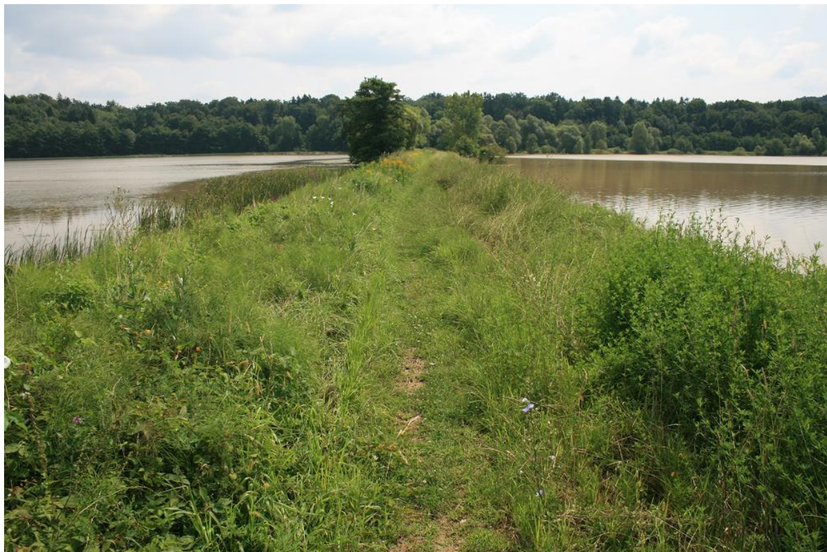
Slika 10: Pogled iz nasipa akumulacije Komarnik, dne 6. 8. 2009 (Iztok Erjavec, 2009)
