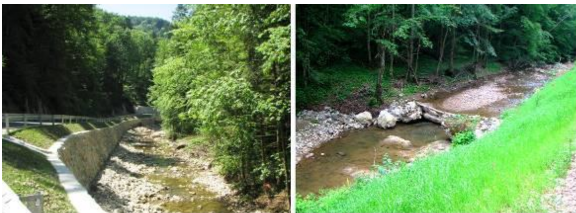
Slika 19: Popisni odsek C. Levo: utrjena leva brežina zaradi podpore ceste. Desno: zajezev iz naravnih materialov, za katero se nabira prod. (foto: Klemenčič, 2009)
