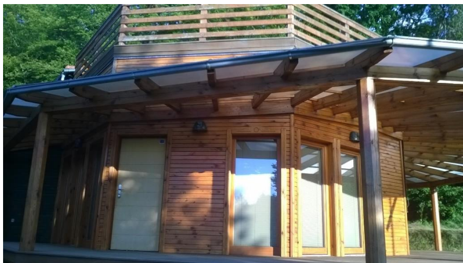
Slika 6: Vidrin informacijski center AQUALUTRA Figure 6: Otter information center AQUALUTRA
