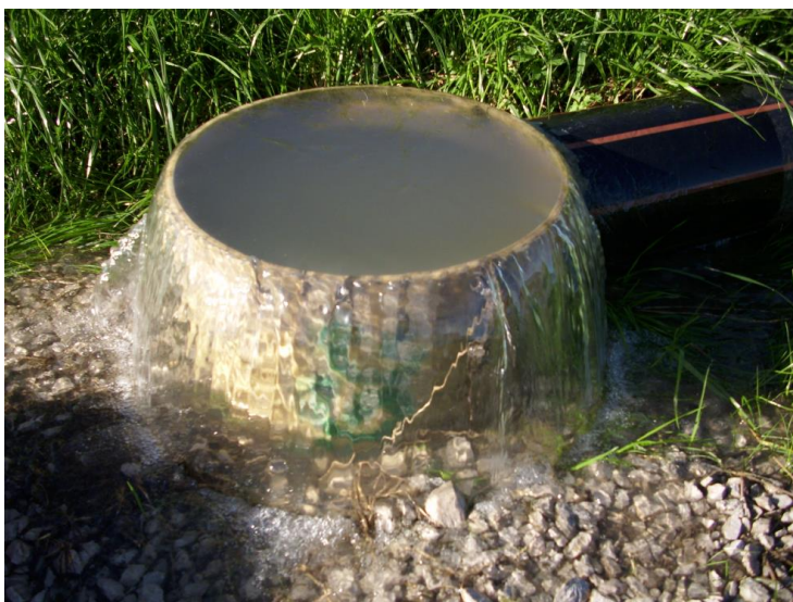
Slika 12: Prelivanje vode čez jašek neposredno po dvigu pokrova na filtrirni gredi RČN Rakitna, opaženo pri vzorčenju V9.
