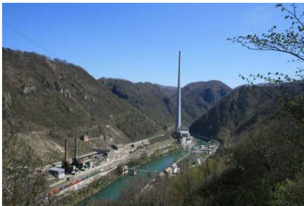
Slika 10: Osamljen, 360 m visok dimnik Termoelektrarne Trbovlje, ki je eden od večjih točkovnih virov onesnažil v Zasavju.
