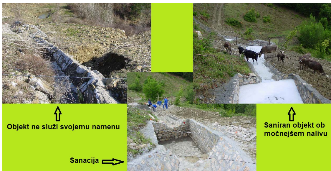
Slika 1: Eden od primerov slabega odvodnjavanja. Slika prikazuje odvodnjavanje z avtocestnega priključka za Črni Kal. Očitno predviden kanal s kamenjem v betonu ni služil svojemu namenu, saj si je voda izdolbla novo korito zunaj urejenega in povzročila veliko erozijsko jedro na kmetijskih površinah. V času pisanja te diplomske naloge je bil objekt uspešno saniran.
