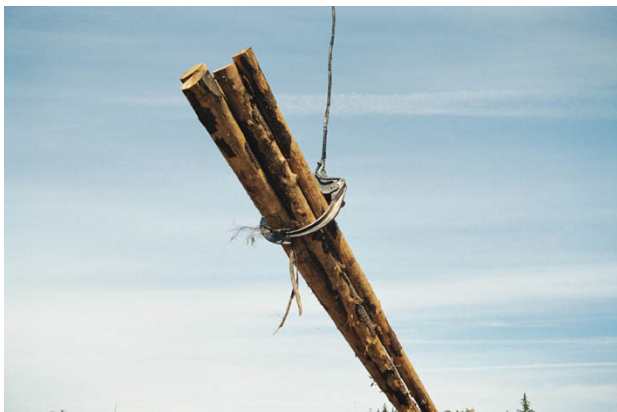
Slika 5: Metoda svežnjev pri helikopterskem spravilu s kleščami (vir: Ericksonaircrane ..., 2007)
