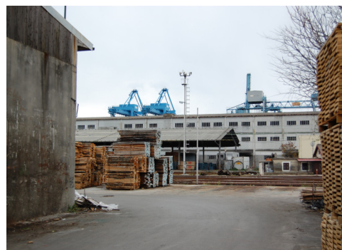
Slika 79: Pogled na skladiščne prostore in upravno stavbo.
