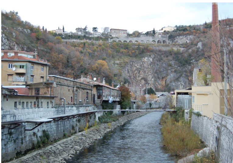
Slika 58: Spodnji del kanjona, ki je v večji meri degradiran in zaseden z ostanki industrijskih objektov.
