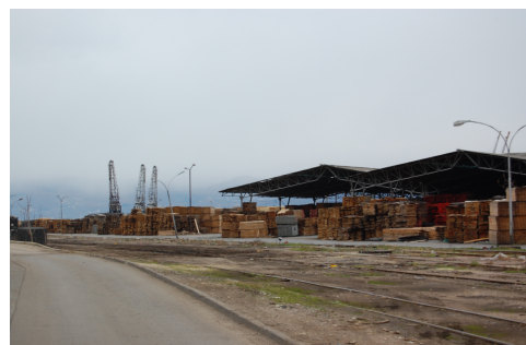
Slika 73: Pogled na odprte in zaprte skladiščne prostore.
