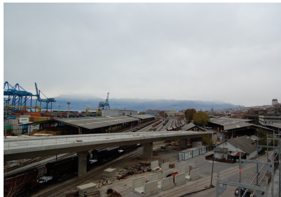
Slika 64: Začetek gradnje ceste D-404. Pogled je na vzhodnem delu Brajdice.
