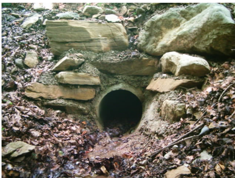
Slika 16: Pravilno urejen iztok cevnega propusta
