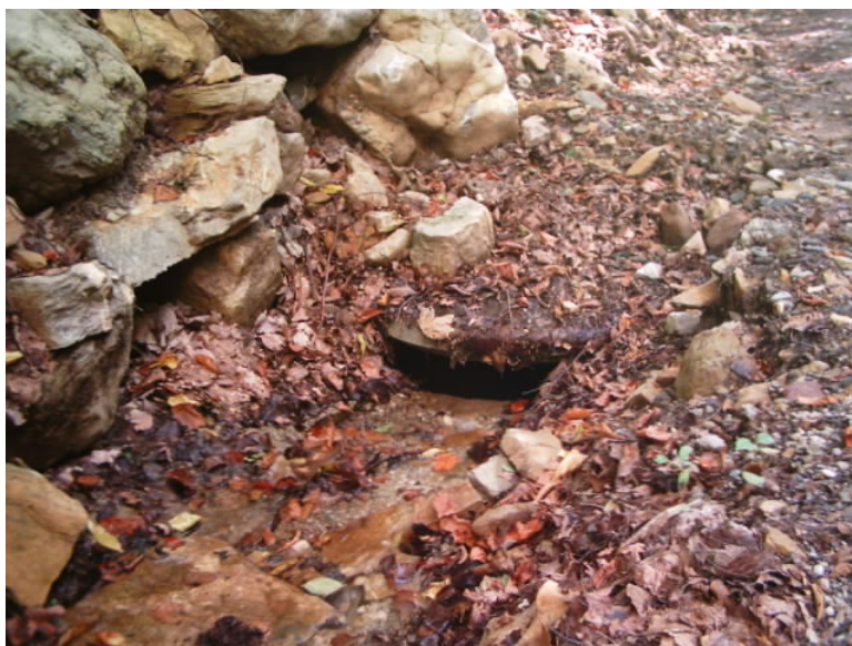
Slika 10: Pokrov vtočnega jaška preprečuje zasipanje
