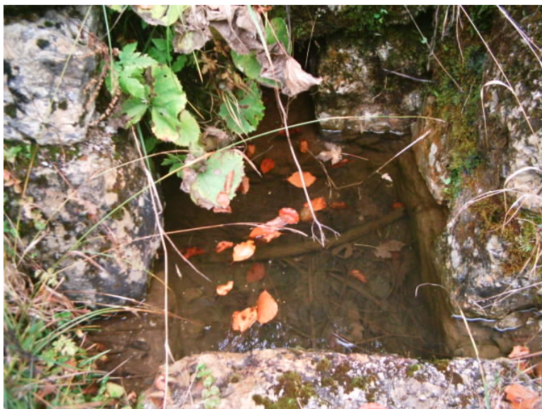
Slika 13: Zamašen vtočni jašek
