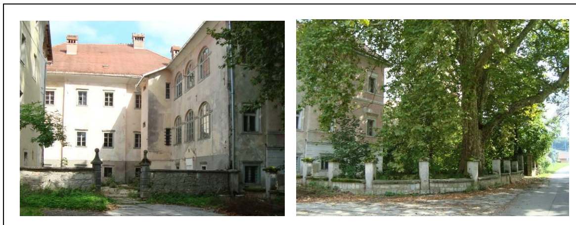
Slika 87: Pogled na zahodni del območja obravnave, kjer stoji edina preostala stara platana. V ospredju je ohranjen zid, sestavljen iz zidanih stebrov
