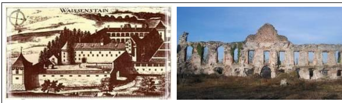
Slika 41: Grad Boštanj iz Valvasorjevih časov (Občina Grosuplje ..., 2009) in danes (Grad Boštanj ..., 2009)
