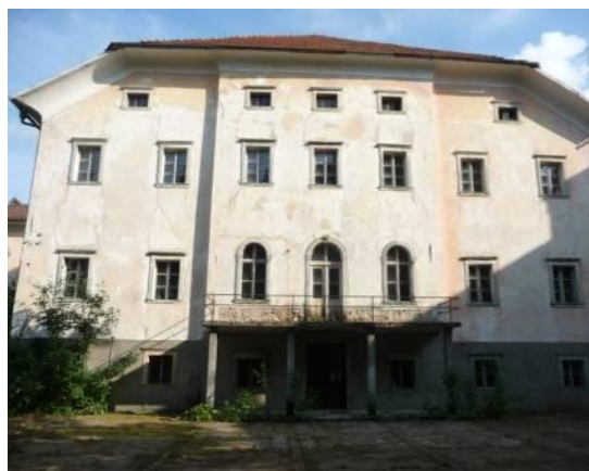
Slika 33: Sedanje stanje severne fasade dvorca
