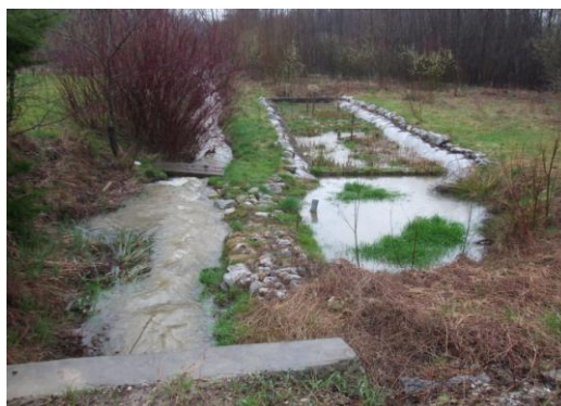
Slika 3: Prikaz poglobljene obstoječe struge (na sliki levo), ki služi kot predusedalnik in s pregrado ločen zgrajen ERM-sistem. Posneto pozimi leta 2009 v času visokih vod (obilne padavine) (Vzdrževanje ..., 2009)
