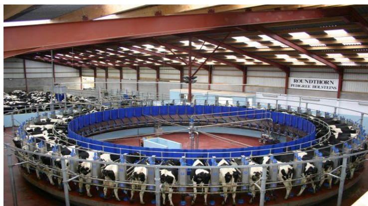
Slika 16: Molzišče rotolaktor (De Laval, 2011)
