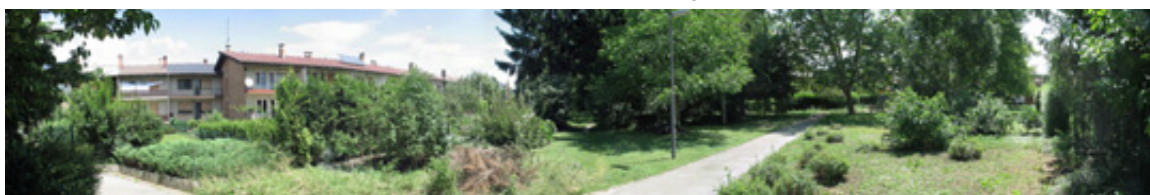
Slika 74 Odprti prostor ob robu naselja – naselje vrstnih hiš Novo Polje (26 LJ) v Ljubljani.
