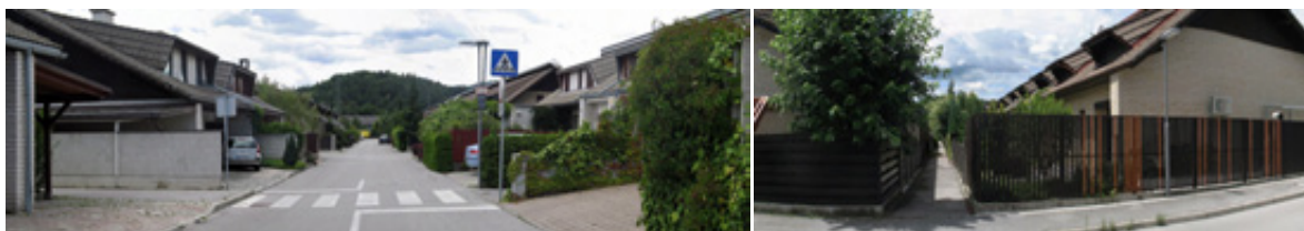
Slika 20 Pogled na cesto med nizoma vrstnih hiš (levo) in pogled proti pešprehodom med vrtovi (desno) v Kamni Gorici (16 Lj) v Ljubljani.
