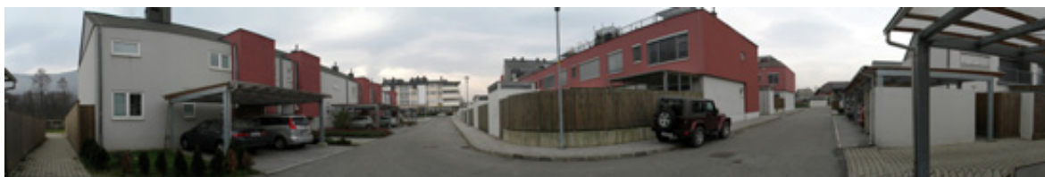
Slika 43 Pogled na naselje vrstnih hiš ob Pohorski ulici (6 MB) v Mariboru.
