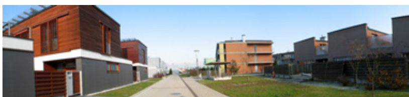
Slika 82 Skupni odprti prostor med nizi vrstnih hiš in večstanovanjskih objektov – naselje vrstnih hiš Mostec (13 LJ) v Ljubljani.
