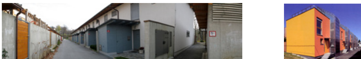
Slika 98 Pešpot – naselje vrstnih hiš v Podbrežju (12 MB) (levo) in vrstne hiše v Radvanju (desno) v Mariboru.
