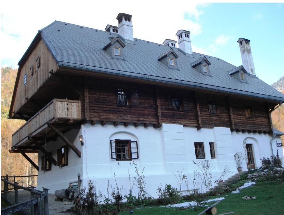
Slika 5: Koča Bodinggraben (foto: Rok Damijan, 2010)
