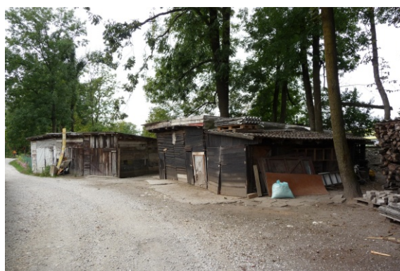
Slika 87: Moteče pomožne objekte okrog stanovanjskih objektov naj se odstrani.
