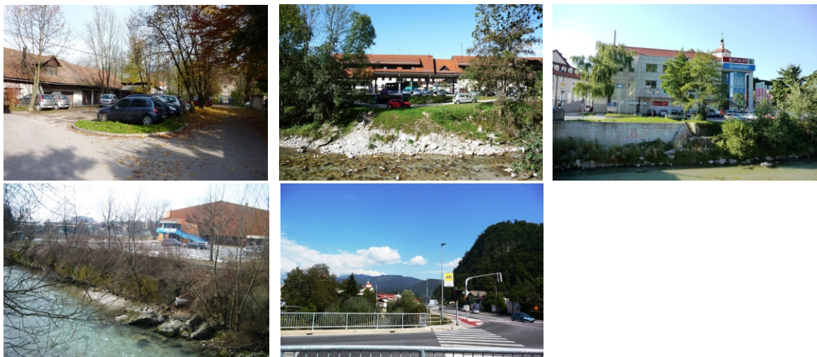
Slika 56: Izbor fotografij prometne infrastrukture, ki sega na območje 15-metrskega priobalnega zemljišča Kamniške Bistrice
