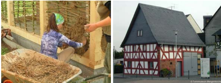
Slika 2 Gradnja z ilovico na predalčni način (Zgodovina gradnje, 2005; Muzej Liskén E. 2007)
