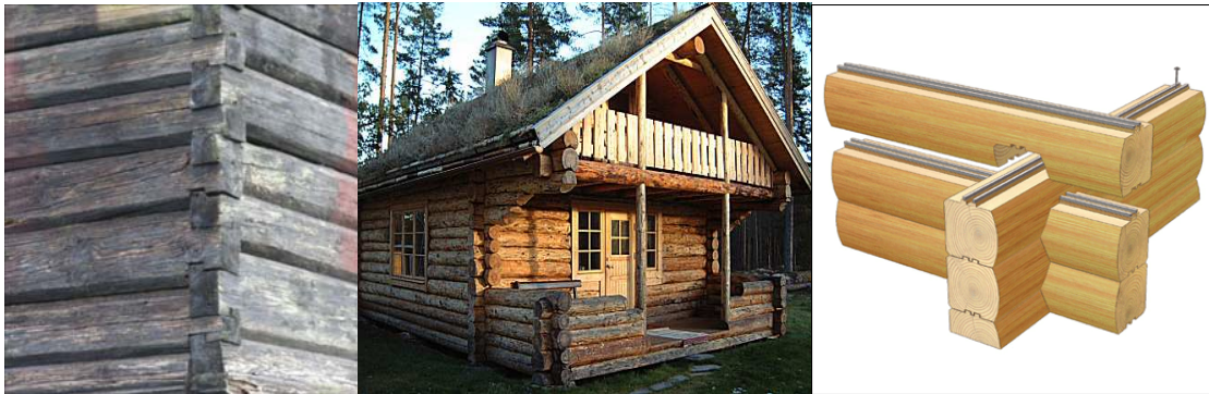
Slika 6 Masivna konstrukcija iz tramov, brunarica in spoj (spoj brunarice iz tramov, brunarica, spoj)
