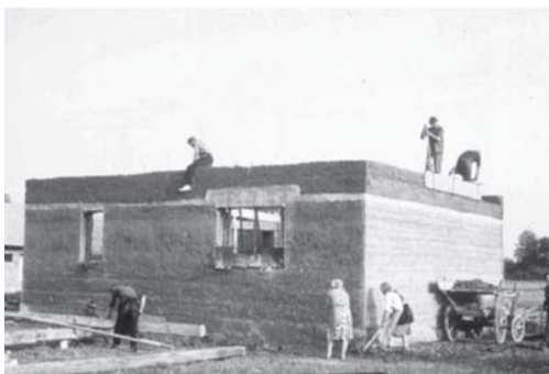
Slika 1 Butanje ilovnatih sten na Ptujskem polju v 70-tih let 20. stoletja (Zbašnik Senegačnik, 2005)
