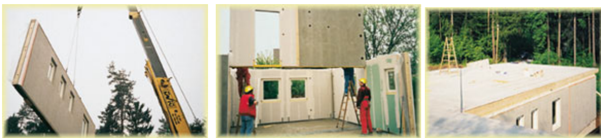
Slika 5 Okvirna konstrukcija (transport, montaža in izgled okvirne konstrukcije, Jelovica 2007)
