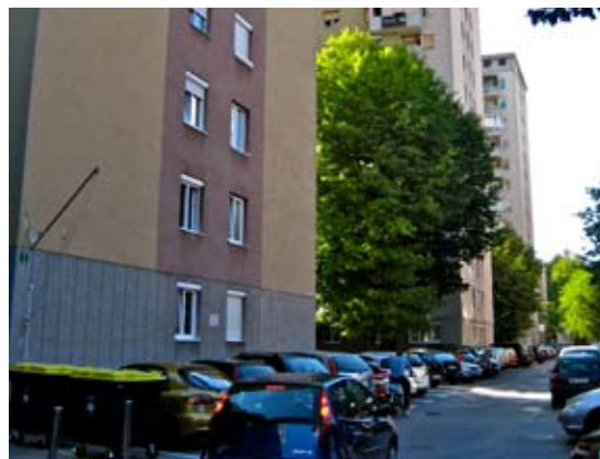
Slika 12: Pogled na cesto B
