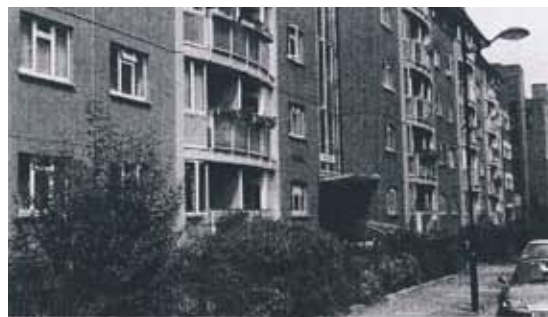
Slika 4: Pred vhodi je sedaj nizko grmičevje, ki poveča kakovost okolja in varnost v njej (Davies 2004: 55)
