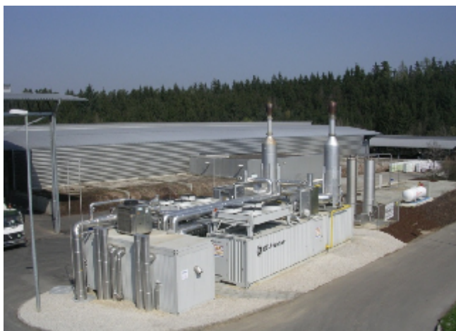
Slika 16: Plinska motorja (Buchheit, 2005)
