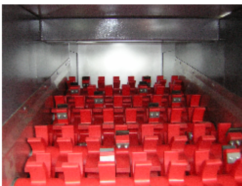
Slika 20: Notranjost naprave za ločevanje biokomposta (Buchheit, 2005)
