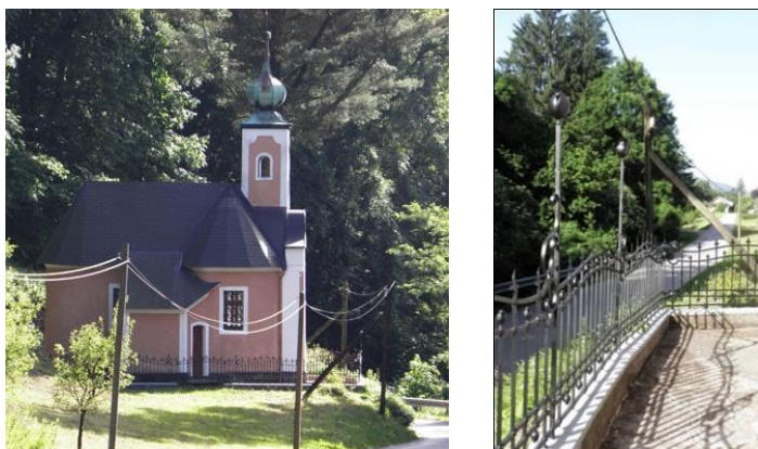
Slika 8: Kapela Matere sedem žalosti ter pogled izpred vhodnega dela kapele proti parku
