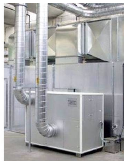
Slika 41: Shema delovanja adsorpcijskega sušilnika in slika adsorpcijske enote (Dry air, 2002).
