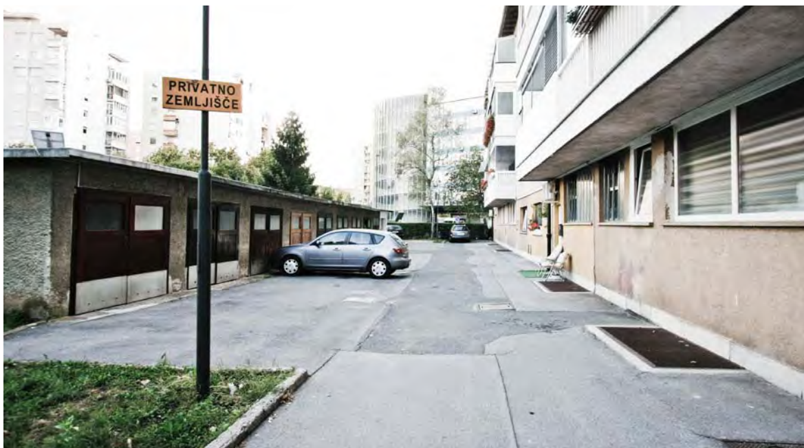
Slika 2: Zapiranje parterja zaradi številnih garaž neposredno ob bloku, Litostroj (14. oktober 2011)
