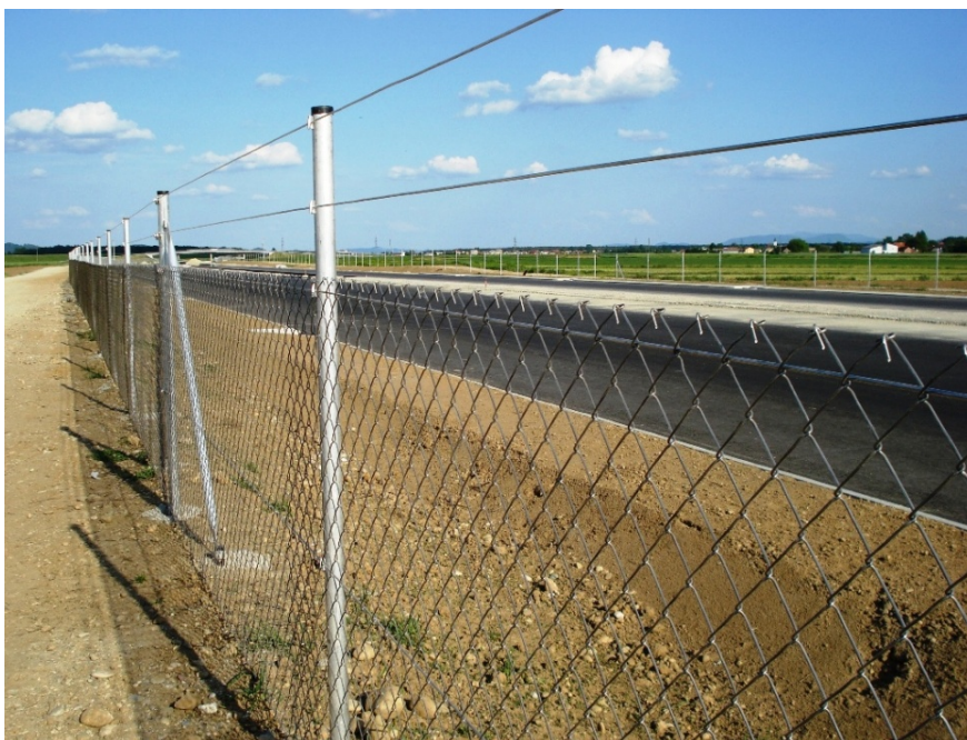
Slika 27: Primer zaščitne ograje vzdolž avtoceste, ki jo lahko medved brez večjih težav prepleza (Los cestna oprema..., 2011)
