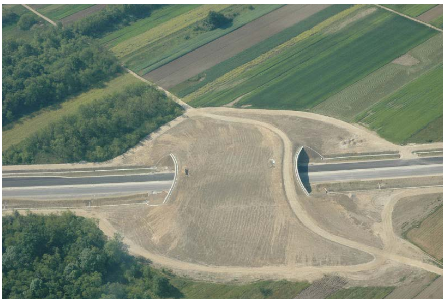
Slika 19: V fazi gradnje zeleni prehod na pomurski avtocesti A5 (DallaValle, 2010)
