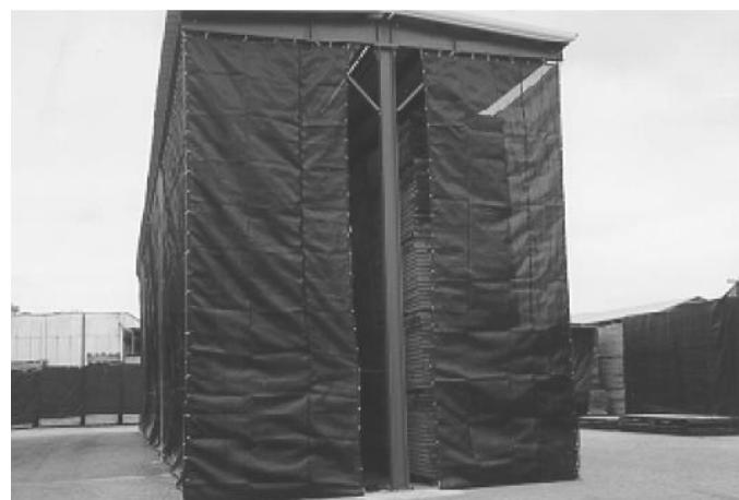
**Slika 2.16:** Primer zasenčenega sušenja v ZDA (Air drying of lumber, 1999)
