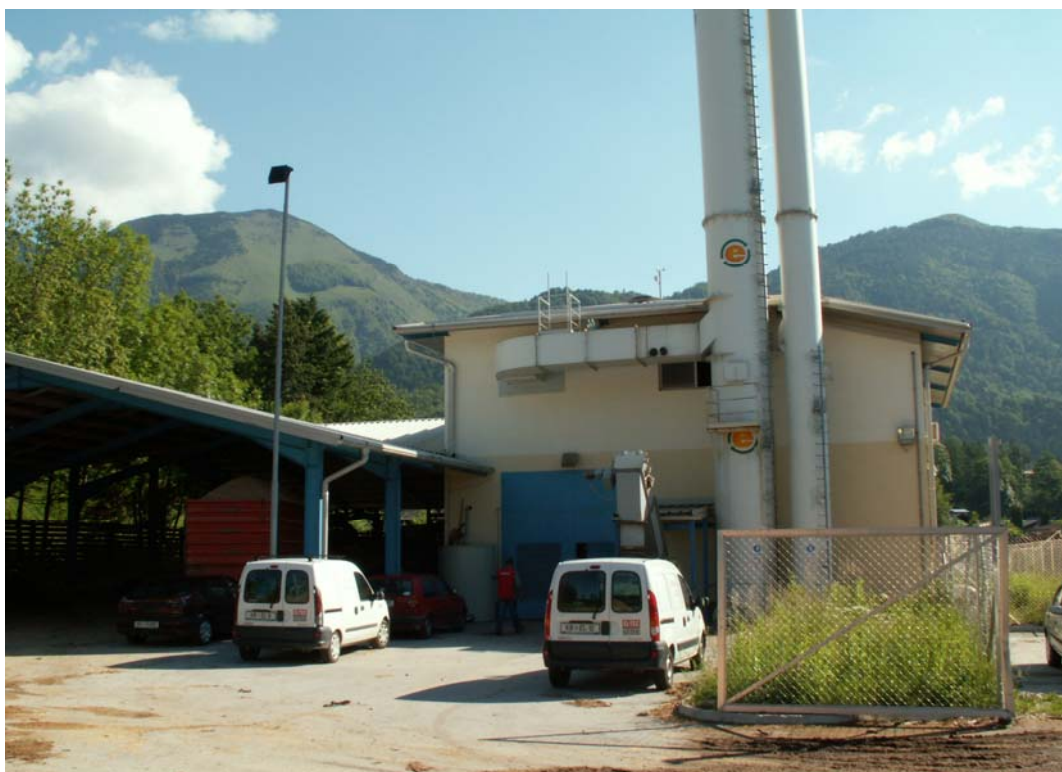
Slika 6: Kotlovnica v Preddvoru
