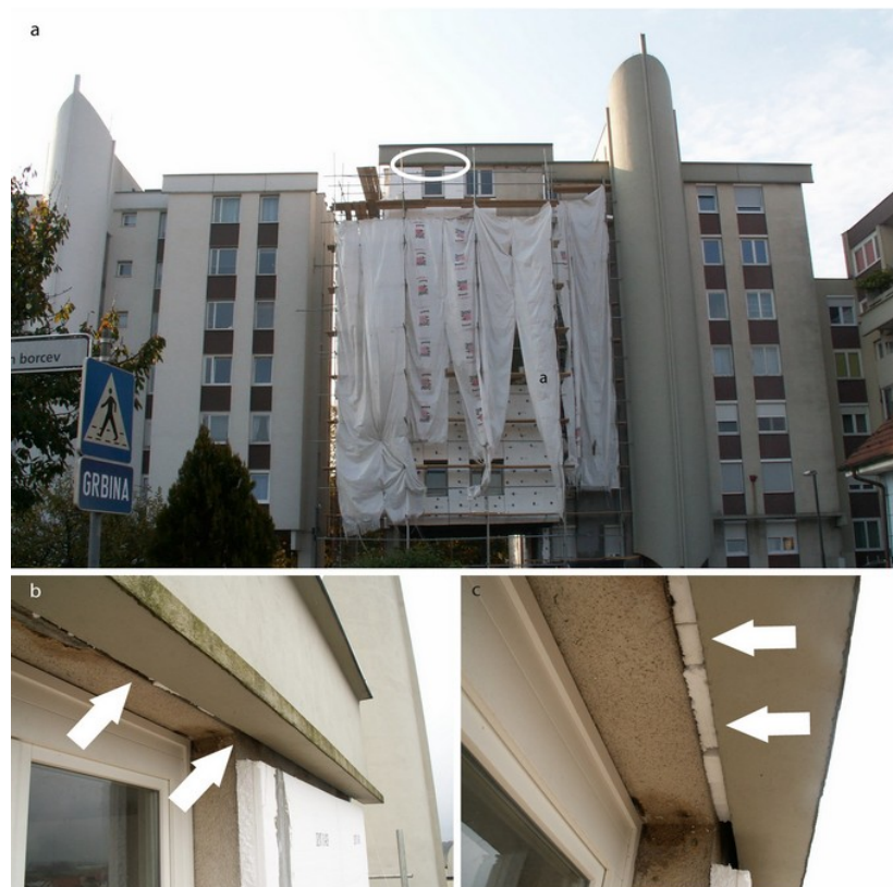
Slika 30: Obnovitvena dela fasade na Kumrovški ulici 11. A – nameščanje izolacije (stiropor), ki je na vrhu zaprla vhod v zatočišče (Foto: Maja Zagmajster), B – špranja nad oknom v sedmem nadstropju, ki so jo netopirji pred obnovo uporabljali za vhod (Foto: Matej Hočevar) in C – zapiranje špranje z stiroporom (Foto: Matej Hočevar).
