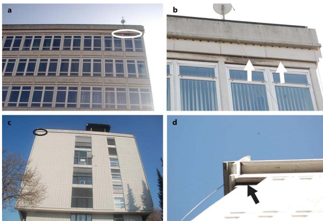
Slika 14: Zatočišči na Fakulteti za gradbeništvo (Jamova cesta 2). Slika A in B – zatočišče usmerjeno proti severozahodu, ter sliki C in D – zatočišče usmerjeno proti jugozahodu (Foto: Matej Hočevar).
