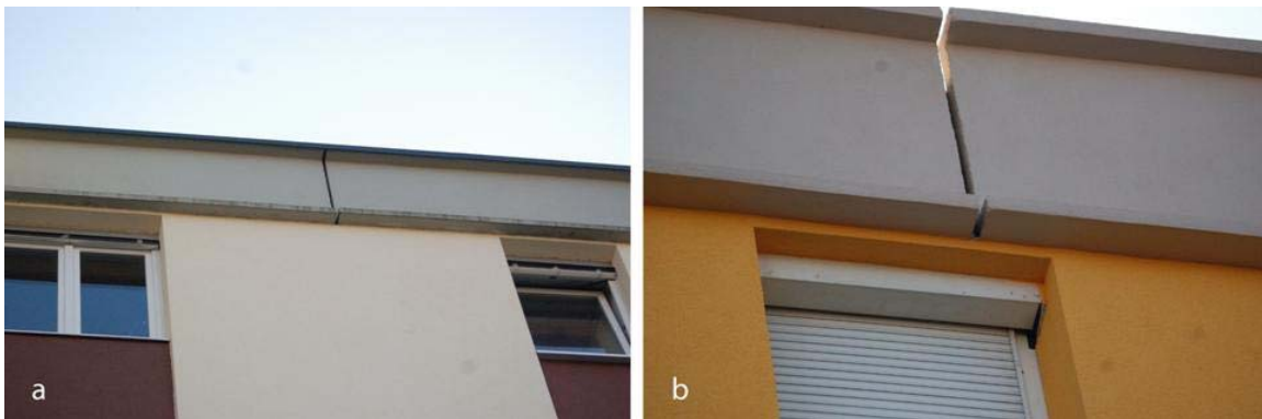
Slika 31: Obnovljeni fasadi; A - na Kumrovški ulici 15 in B – na Kumrovški ulici 17 (Foto: Matej Hočevar).
