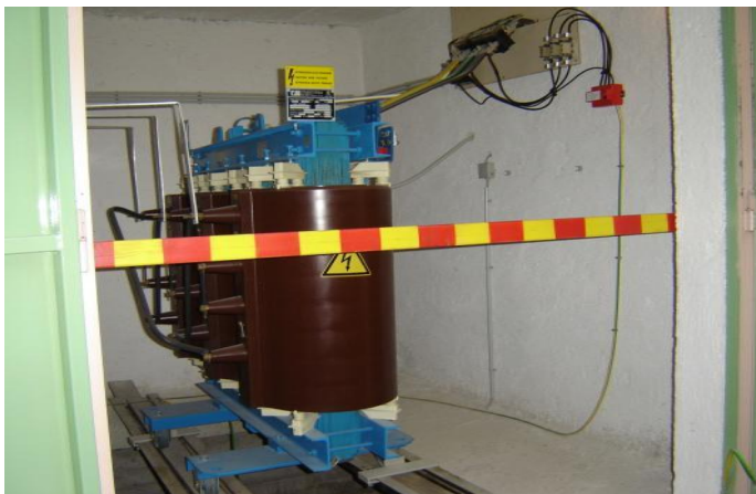
Slika 22: Transformator – suha izvedba 600 kVA
