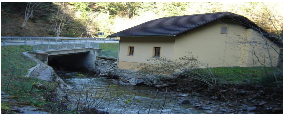
Slika 18: Mala hidroelektrarna Hohler
