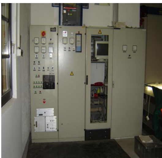
Slika 24: Elektro omara z avtomatiko
