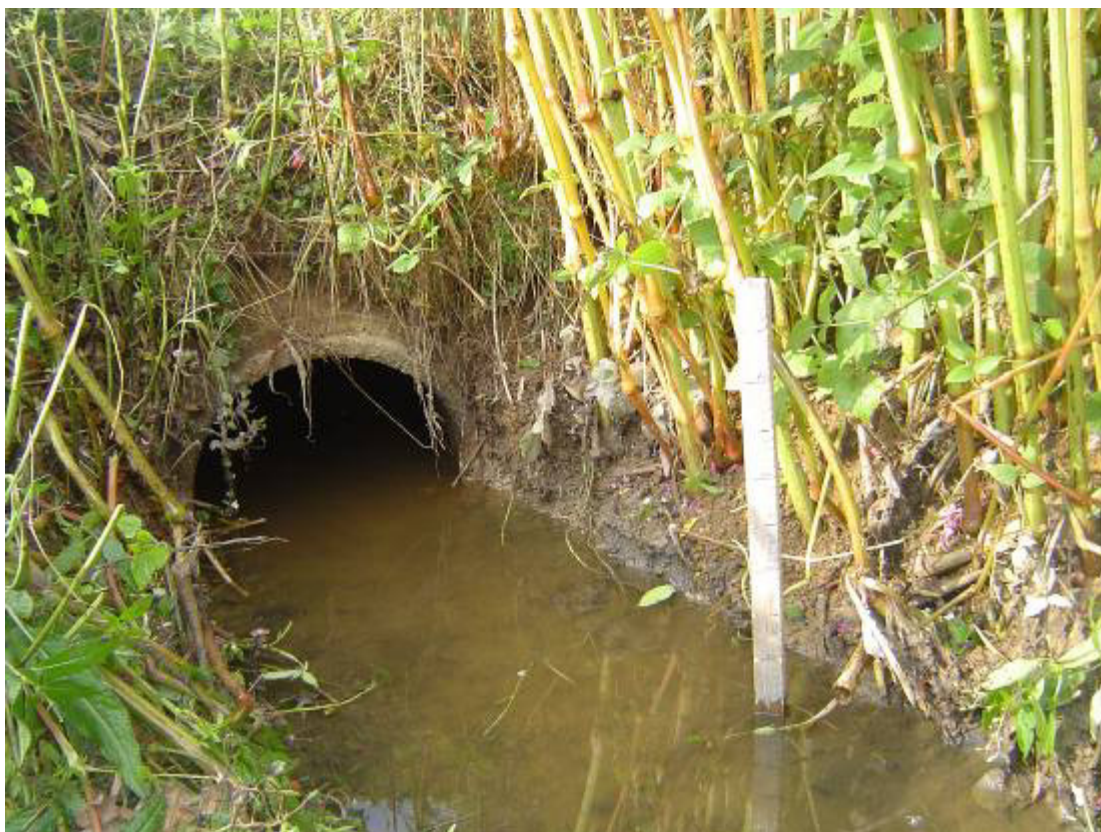
Slika 10: Iztok odpadnih voda z Rakeka po cevnem sistemu v ponikalnico, merilno mesto za pretoke in odvzem vzorcev. (Foto: Ileršič T., 2006)
