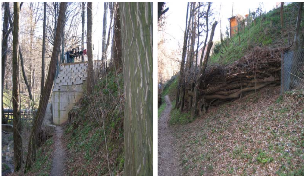
Slika 16: Improvizirani oporni zidovi ob robu gozda.
