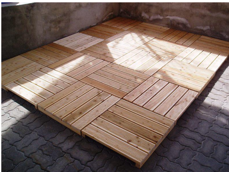
Slika 3: Lesen pod iz že izdelanih plošč dimenzije 50 cm x 50 cm (Informativno gradivo Jurij Jene, s. p.)
