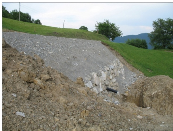
Sanacija enega od usadov na cesti Murave – Žetina (foto: Jerman Zala, junij 2011)
