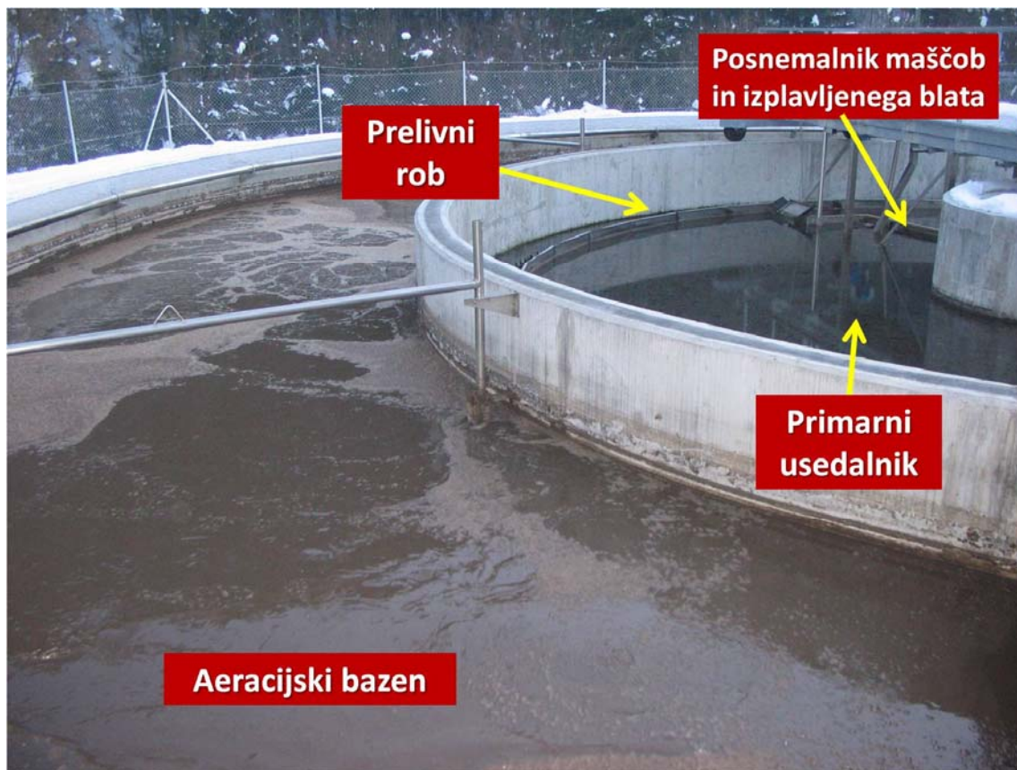
Slika 7: Aeracijski bazen s primarnim usedalnikom, posnemalnikom maščob ter prelivnim robom
