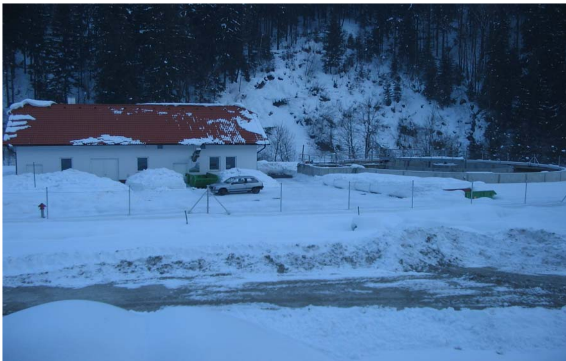
Slika 1: Čistilna naprava Mežica
