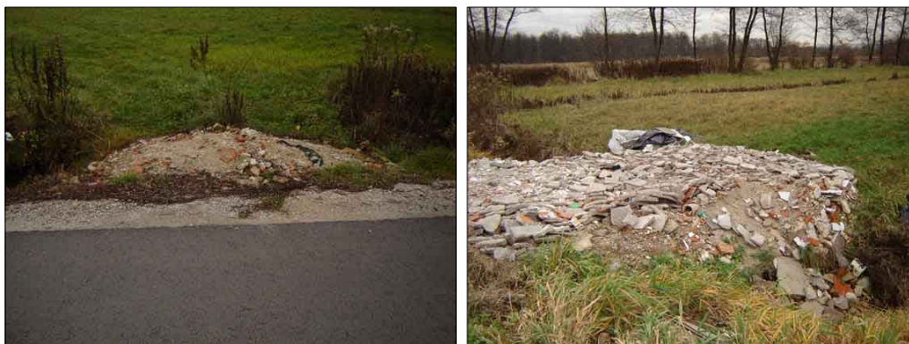
Sliki 35, 36: Nasutje gradbenega materiala za utrjevanje tal (ob cesti Brest) in nasutje za utrjevanje tal, kjer je gradbeni material pomešan s kosovnim odpadom (ob cesti v vas Matena).
