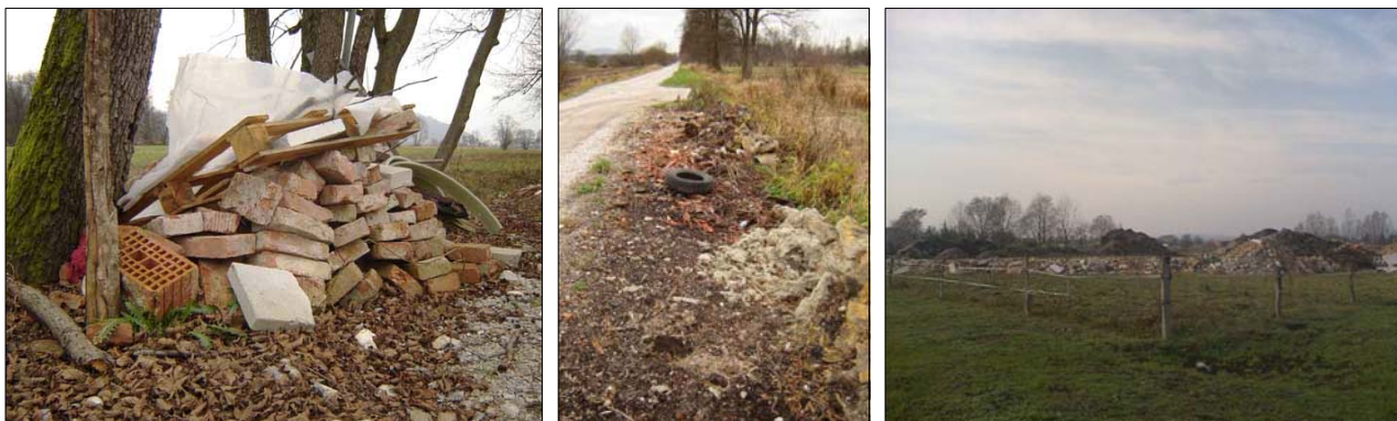
Slike 25, 26, 27: Točkovna (ob cesti Brest), linijska (ob križišču ceste Brest in Brglezovega štradona) in ploskovna oblika (med Ižansko cesto in reko Iščico) odlagališča gradbenega materiala
