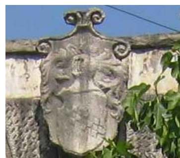
Slika 25: Detajl nad vhodnim portalom
