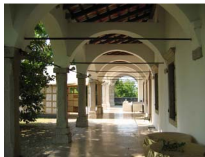
Slika 53: Arkadni hodnik raztaplja ločnico med notranjostjo dvorca in odprtim prostorom parka
