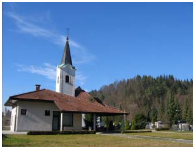
Slika 15: Mrliška vežica je del novega pokopališča, kjer je še malo grobov. Sčasoma bo vežica postala njegovo središče.
