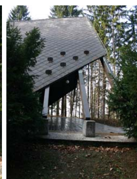
Slika 34: Zaključki strehe so eden od zanimivih detajlov.
