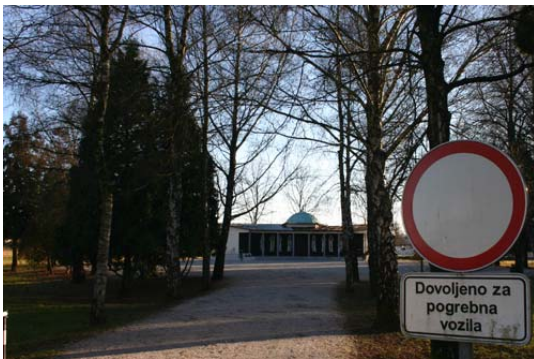
Slika 26: Glavna dostopna cesta je označena z zapornico in tablo, ki prepoveduje ves promet, razen pogrebnih vozil.
