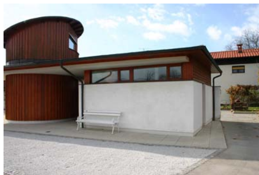
Slika 11: Stranski dostop do novega servisnega objekta.
