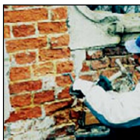
Slika 18: Iščenje reže med opečnimi zidaki (Roefix gradbeni sistemi, 2010: 187)
