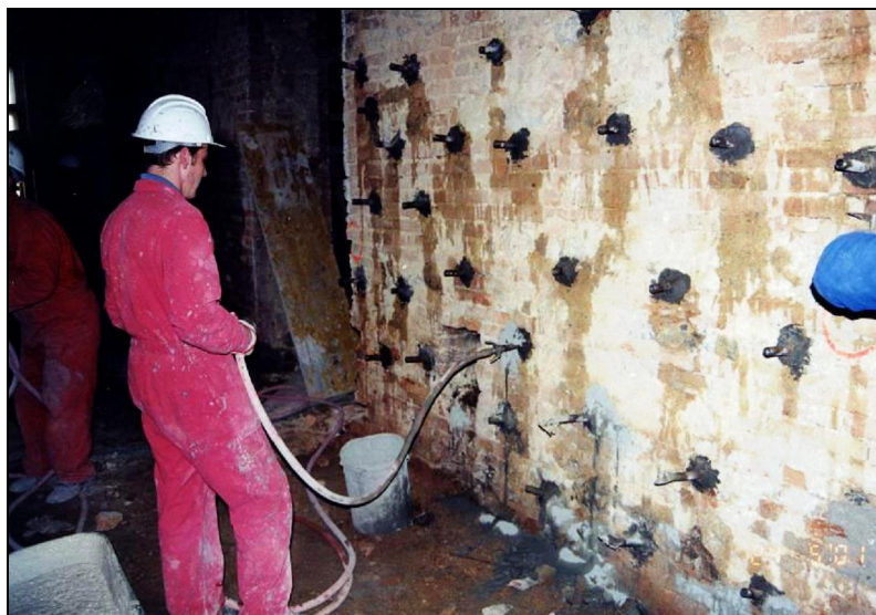
Slika 17: Injektiranje zidu (Bergant in Dolinšek, 2010: 9).
