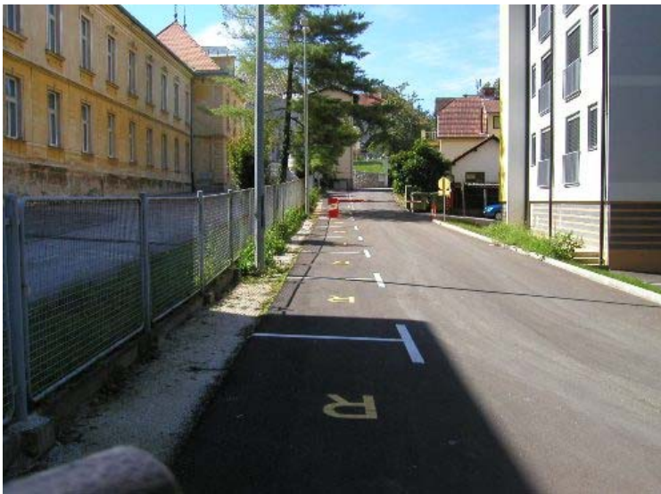
Slika 28: Spuščena zapornica na odseku A
