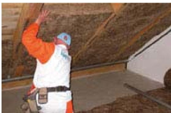
Slika 2: Slamnata izolacija ostrešja ( http://www.knaufinsulation.si )
